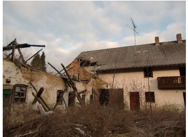
Abbildung 2: Wohngebäude mit Nebengebäude (Blick von Süden)
