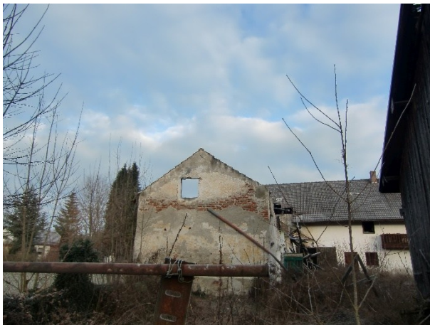
Abbildung 7: Nebengebäude (Blick von Süden)
