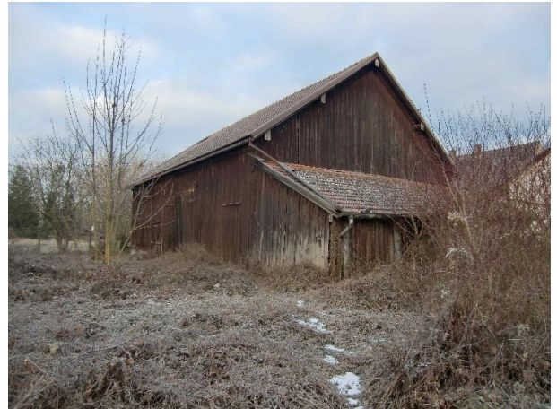
Abbildung 6: Scheune (Blick von Südosten)
