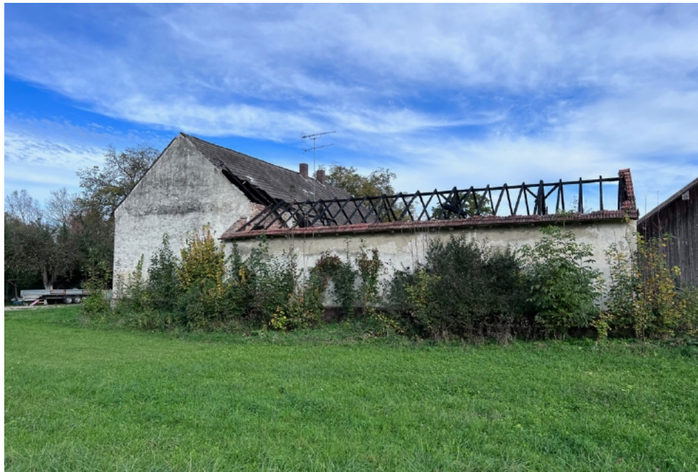
Abb. 2a: Ansicht von Westen, Foto kaa (Oktober 2022)
