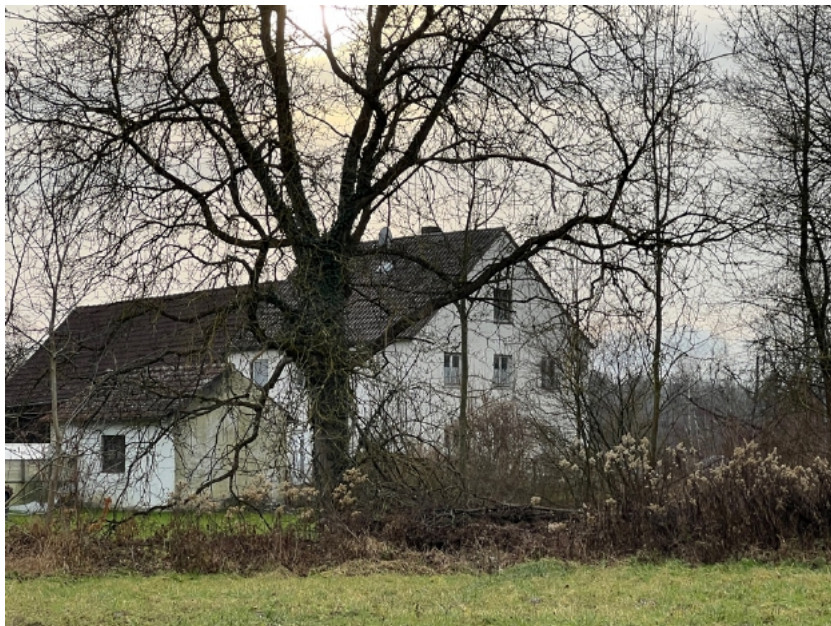
Abb. 4d: südwestliche Nachbarbebauung, Foto kaa (Dezember 2024)
