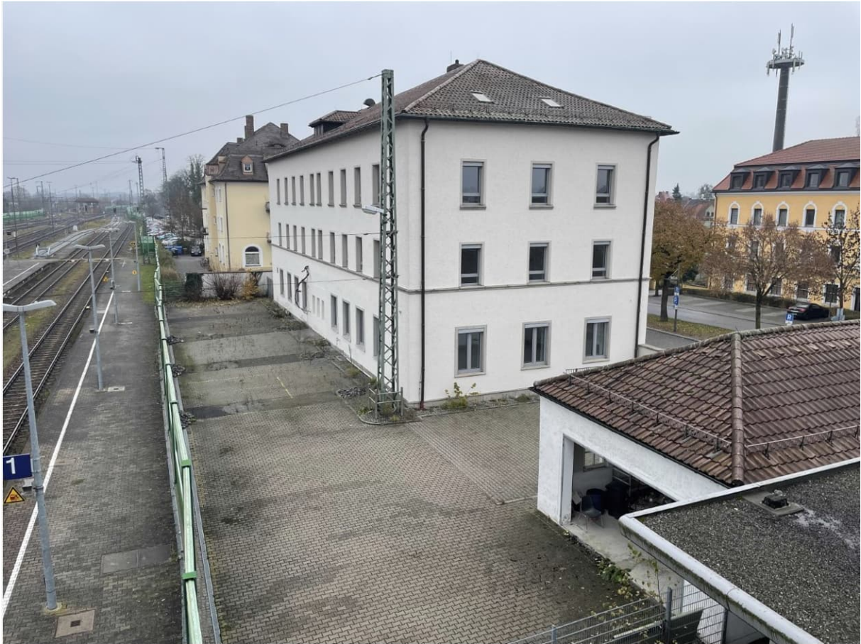
Blick von Nordwesten (Foto: Roman Hiendlmaier, 12/2024)
