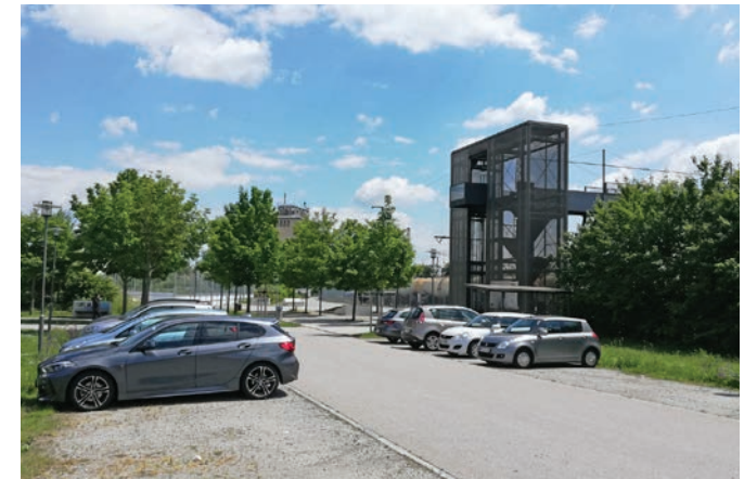
Stellplatzfläche mit Zugang Steg nördlich der Gleise
