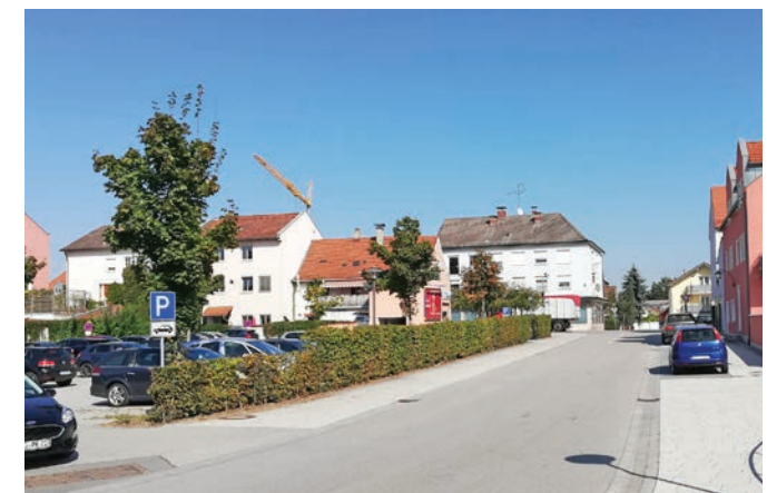
Fehlende bauliche Kante an der Preysingstraße
