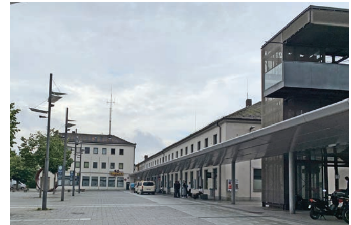
Treppenturm des „Eisernen Stegs“ am Bahnhofsvorplatz
