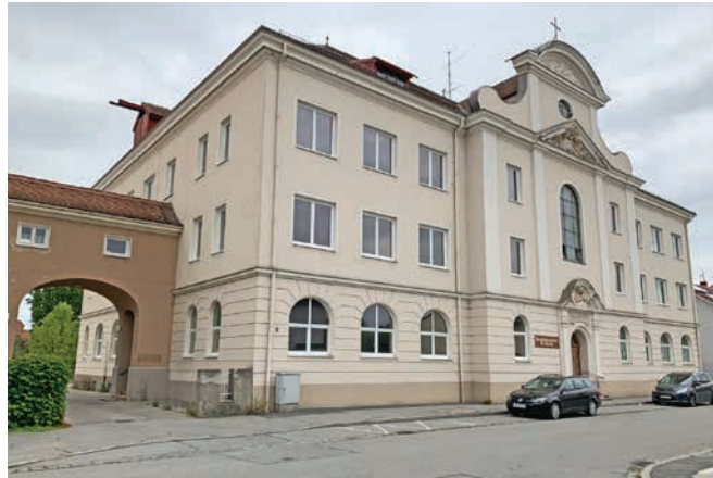
Markante Fassade in der Schulstraße
